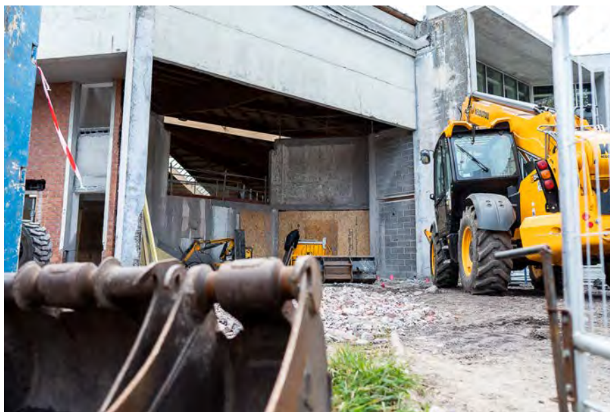
📍 Le chantier de réhabilitation et d'extension du dojo de Wasquehal
